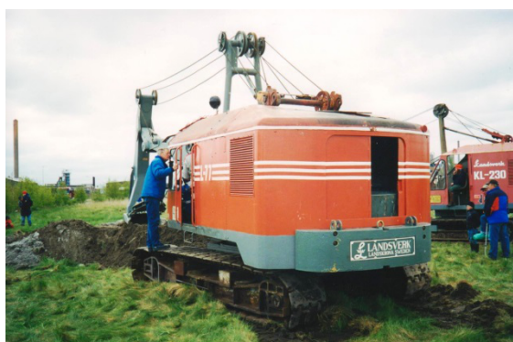
Den gamla maskinen på Landsverk igen den 15/5 1999
